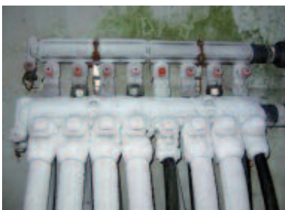
△ Abb. 1 Eingefrorener Erdwärmesondenverteiler (aus [6])
