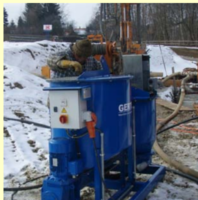
Costruzione di pozzi
