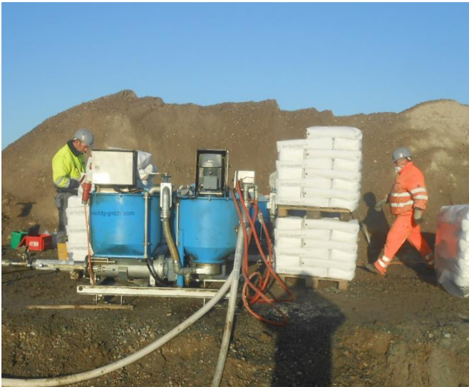
Kolloidalmisch- und Verpressanlage, Verarbeitung von Sackware (li.), Überlaufkontrolle (re.)
