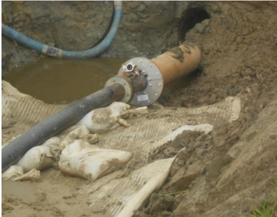
HDG - RoKa PM@HDG – Verschlusselement am Einfüllende (links) und Überlaufende (rechts)
