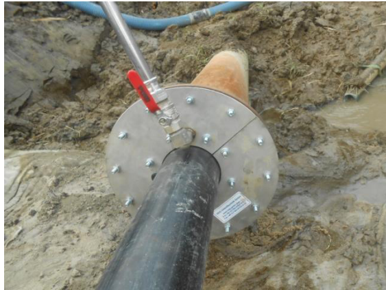
HDG - RoKa PM@HDG – Verschlusselement am Einfüllende (links) und Überlaufende (rechts)
