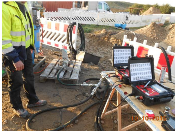
Sicherung und Verfüllung von PE-Schutzrohren (Landseite) mit einliegendem Hochspannungskabel
