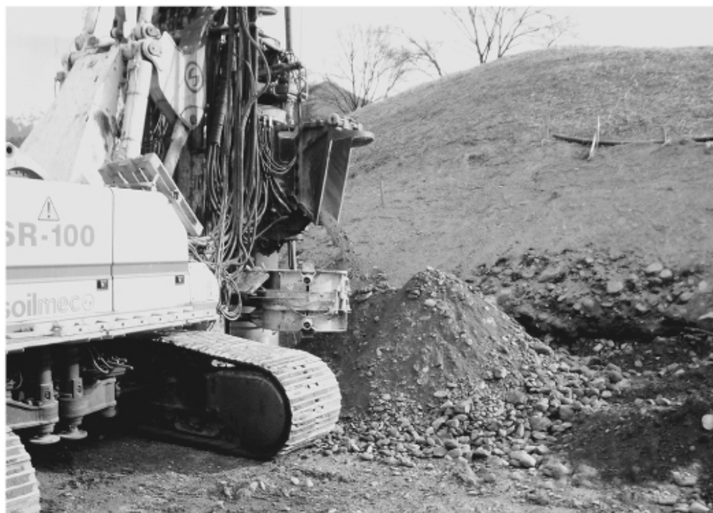
Das „Flaggschiff“ SR-100 von Soilmecc ist mit einer Motorleistung von 480 kW und einer Drehmomentkombination von 330/448 kNm auf den Drehantrieben ausgestattet. Damit wird eine tägliche Bohrleistung von bis zu 85 Bohrmeter bei 1200 mm Durchmesser erzielt. Fotos: Soilmecc
