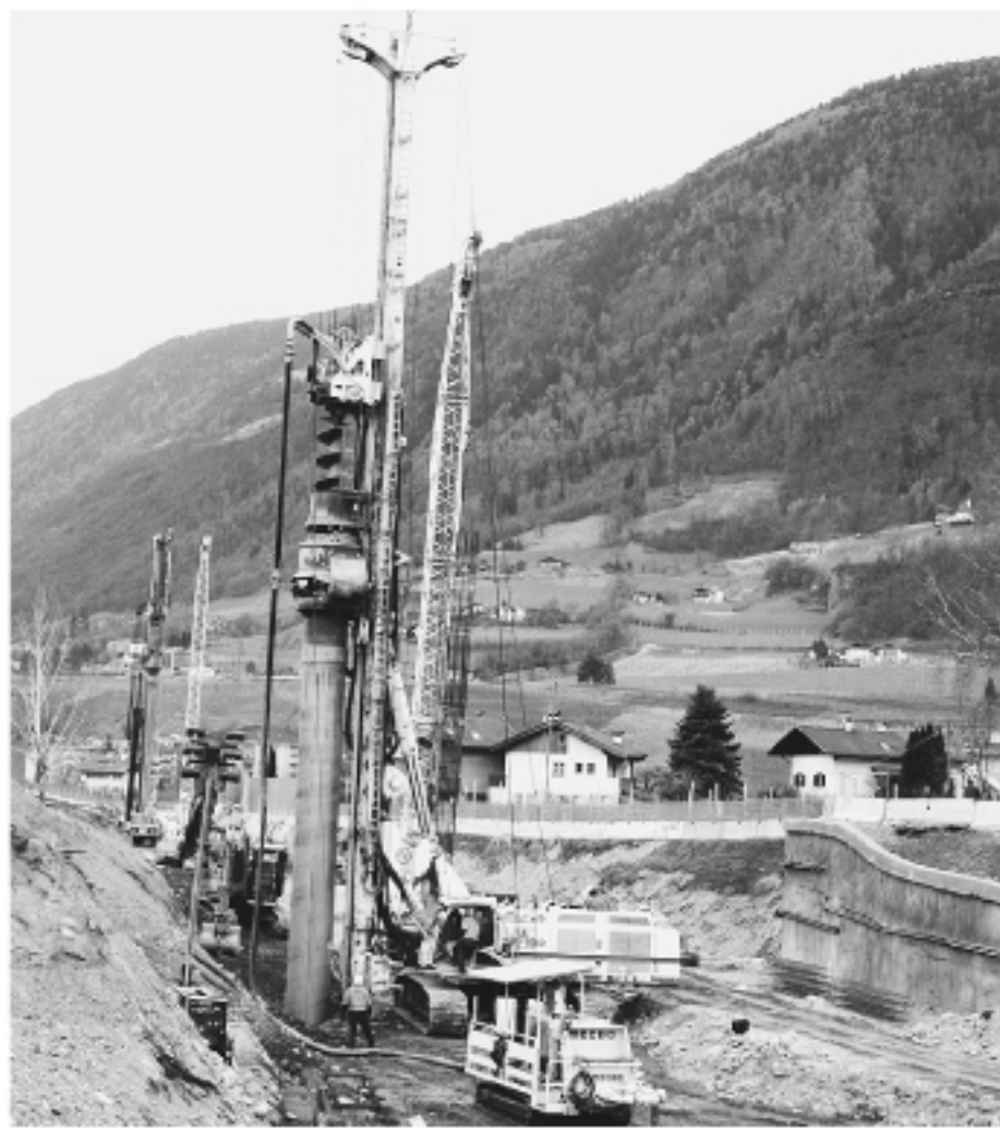
Die verschiedenen Bohrdurchmesser werden durch die Maschinentypen SR-80, SF-120 und SR-100 ausgeführt, die alle mit Doppeldrehantrieben ausgestattet sind.
